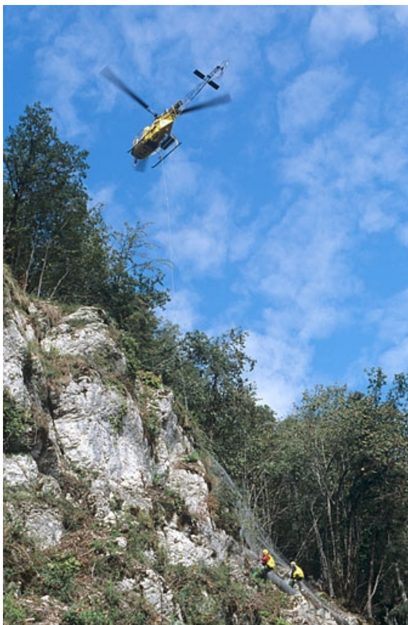
Sécurisation de paroi rocheuse à Syam : ancrage des rouleaux de filets de protection.
