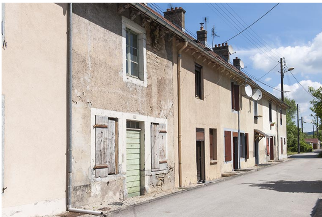
Façade sud d'un logement de type caserne.
