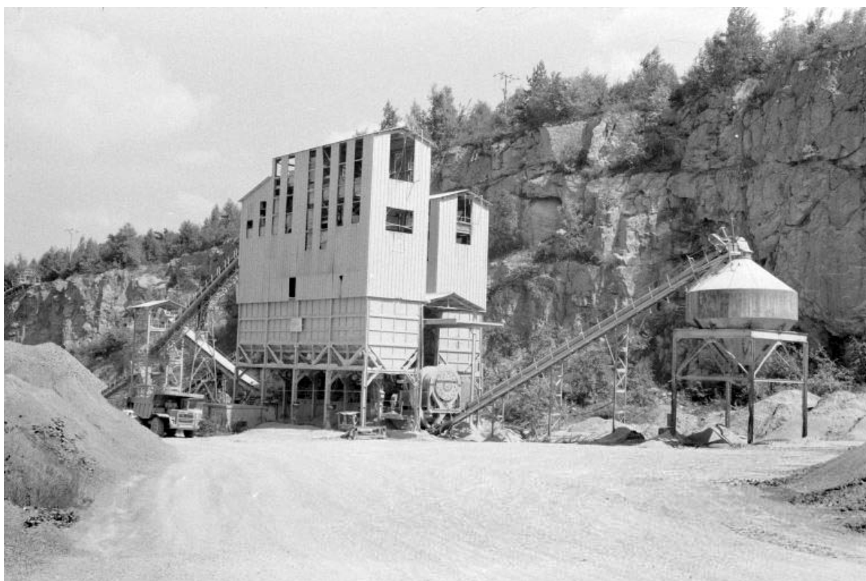
Nouvelles installations de concassage, en 1988.
