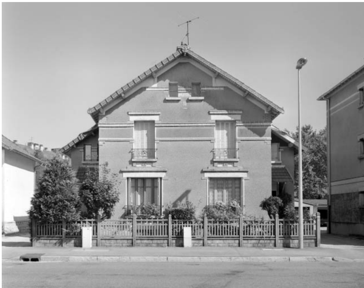
Façade antérieure d'un logement double (cadrage horizontal).
