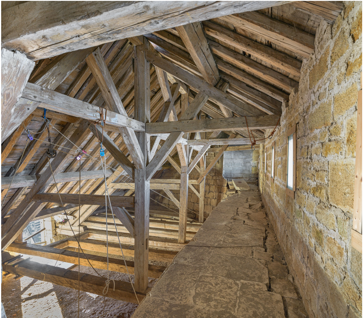
2e étage : charpente du bâtiment.
