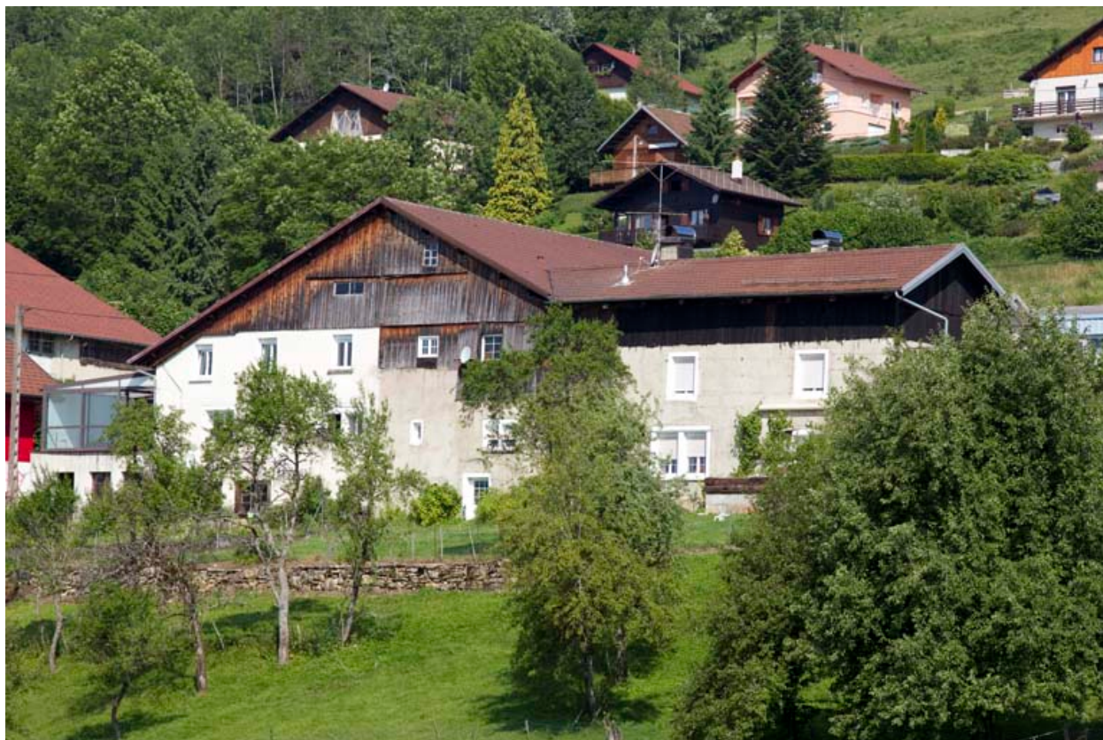
Vue d'ensemble rapprochée depuis le sud-est.
