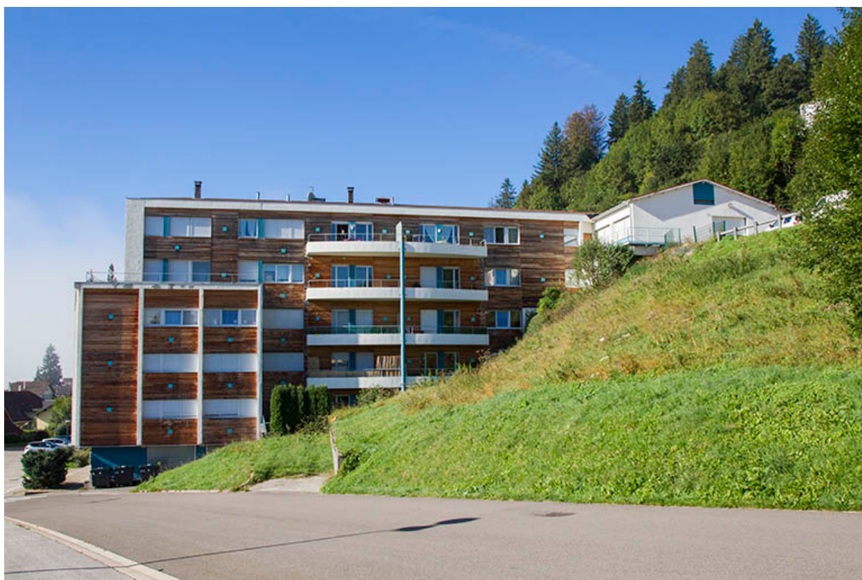
Façade latérale droite.
