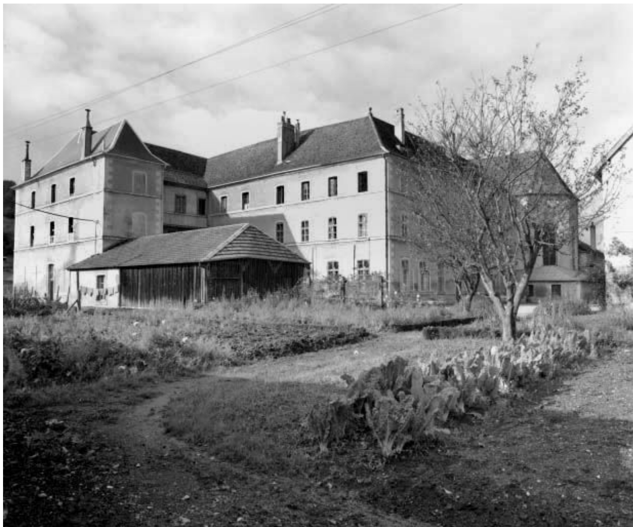
Vue d'ensemble des bâtiments depuis l'angle nord-est.
