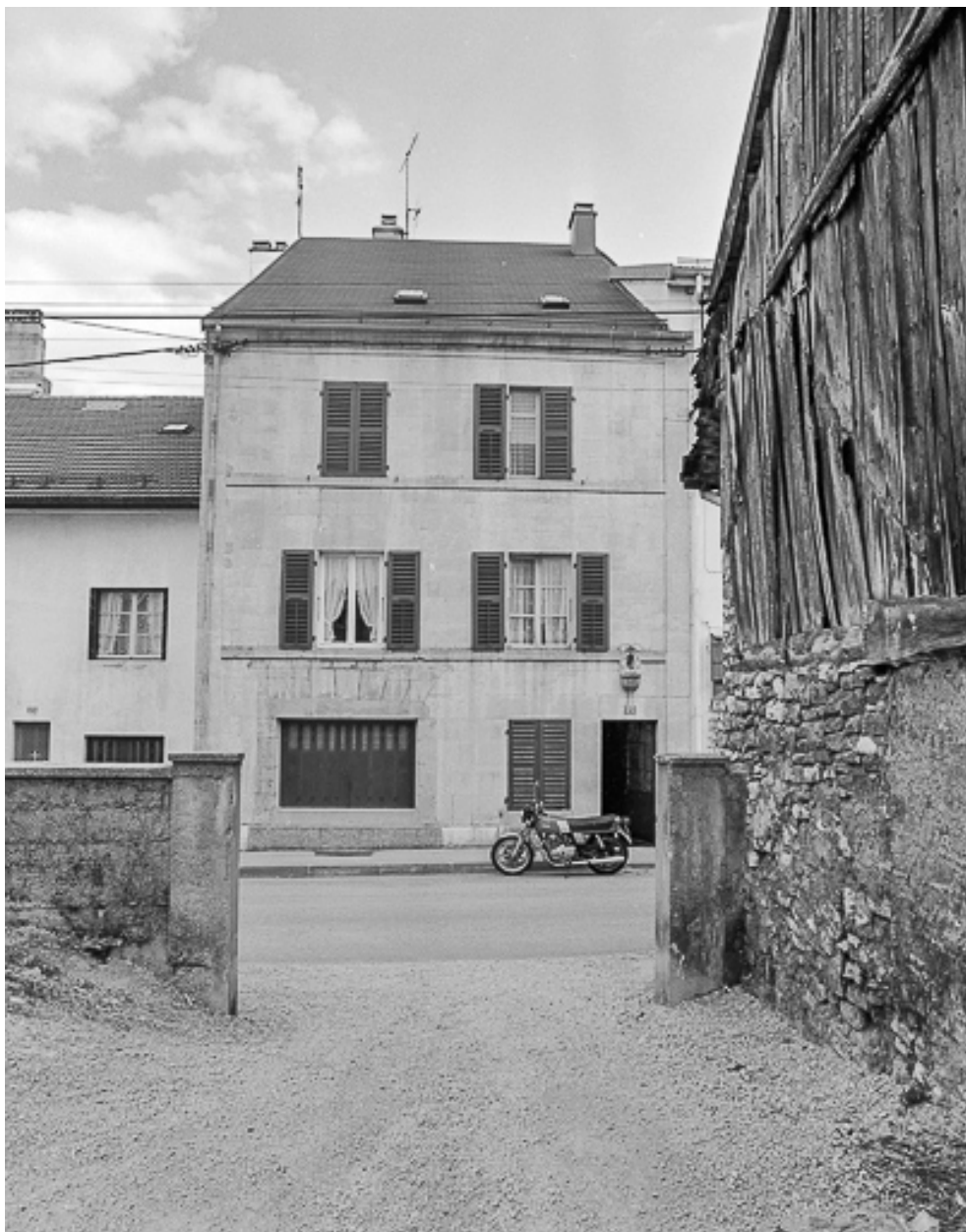
Maison située 25 rue Montrieux.
