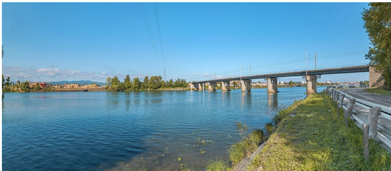
Le pont vu d'aval, rive gauche.
