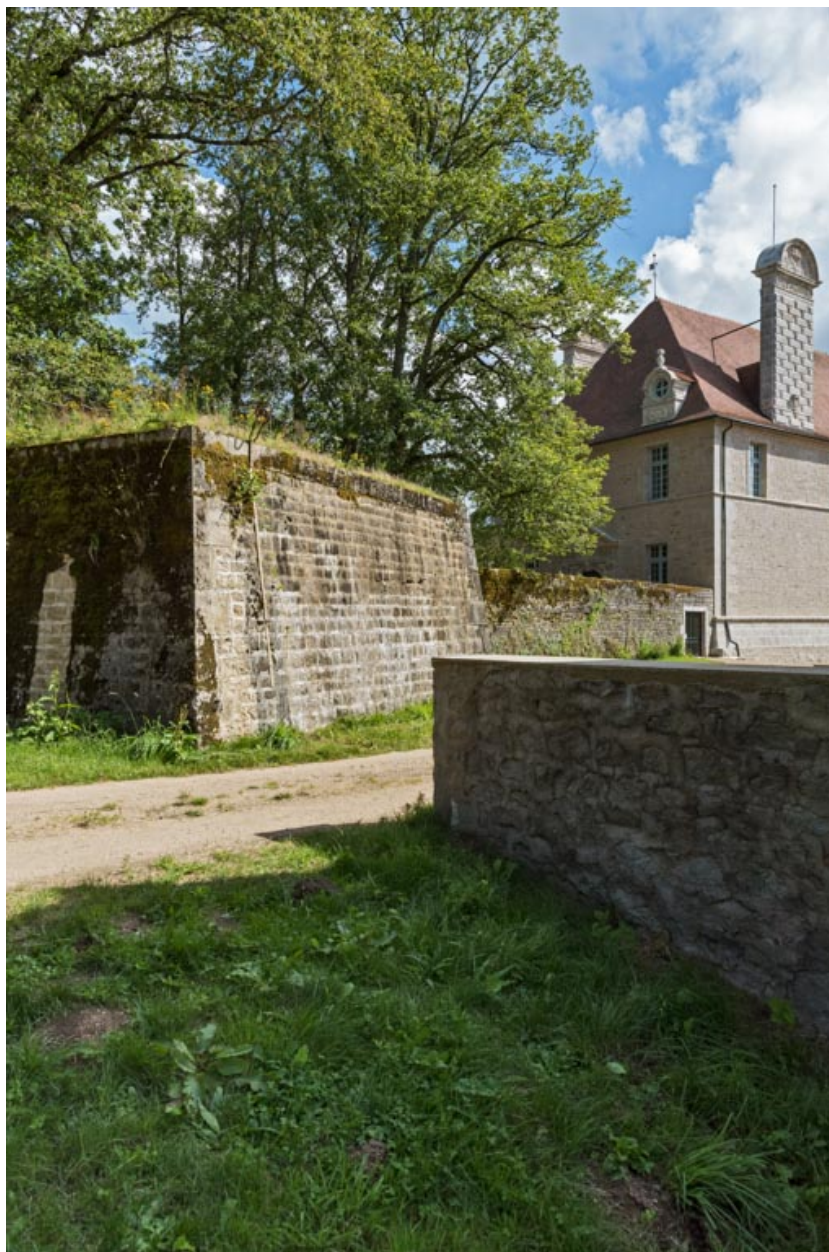
Mur d'enceinte, vue depuis le nord.
