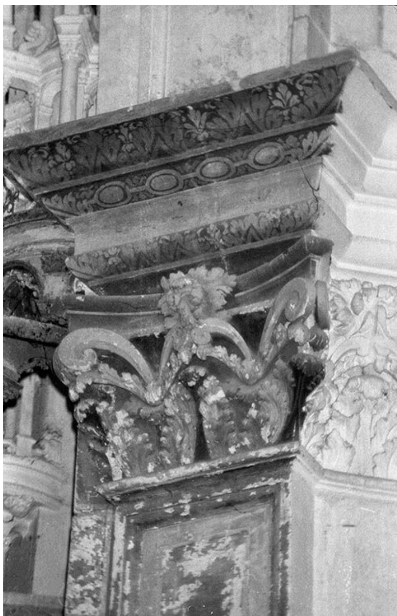
Chapiteau d'un pilier du choeur.
