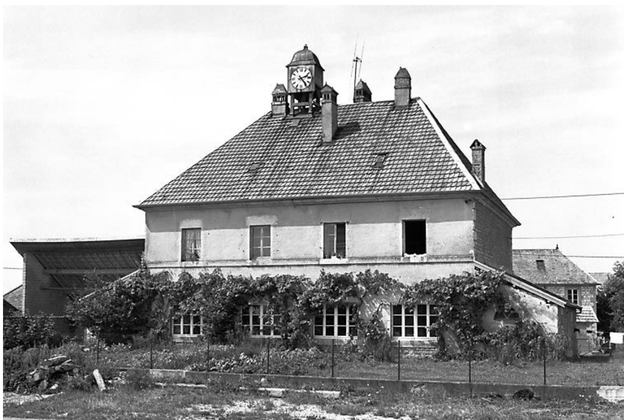
Ecole située rue de la Bascule.
