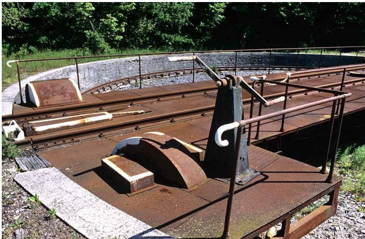
Poste de manoeuvre.
