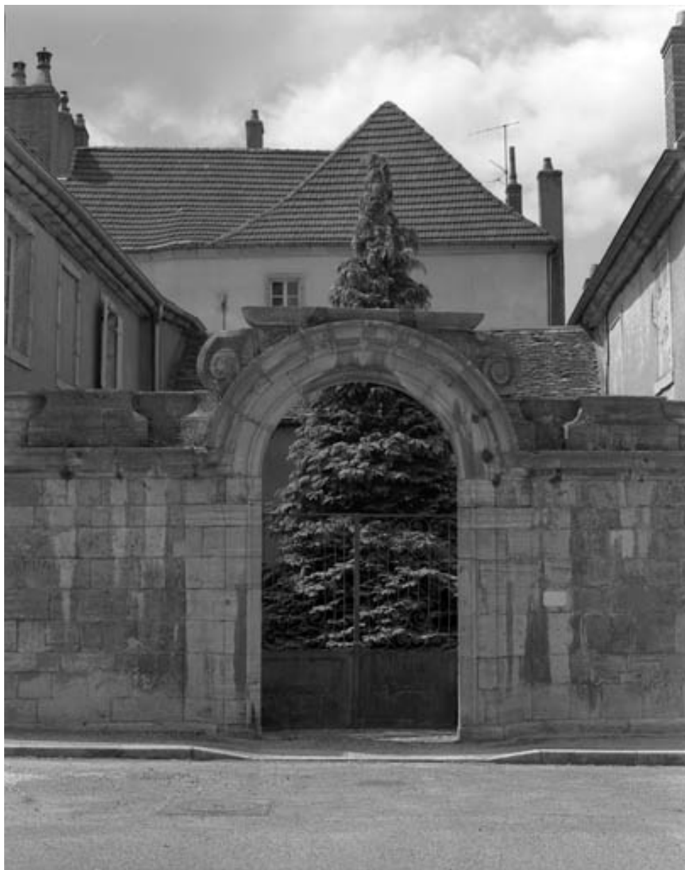
Portail d'entrée droit, depuis la place.
