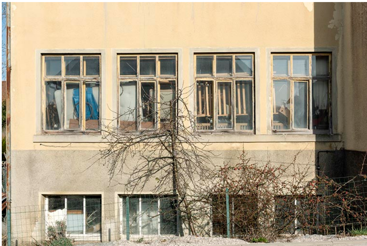
Aile orientale : fenêtres multiples.
