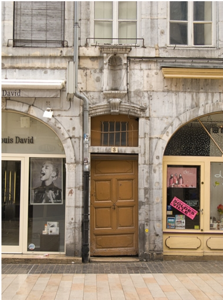
Détail de la porte d'entrée.
