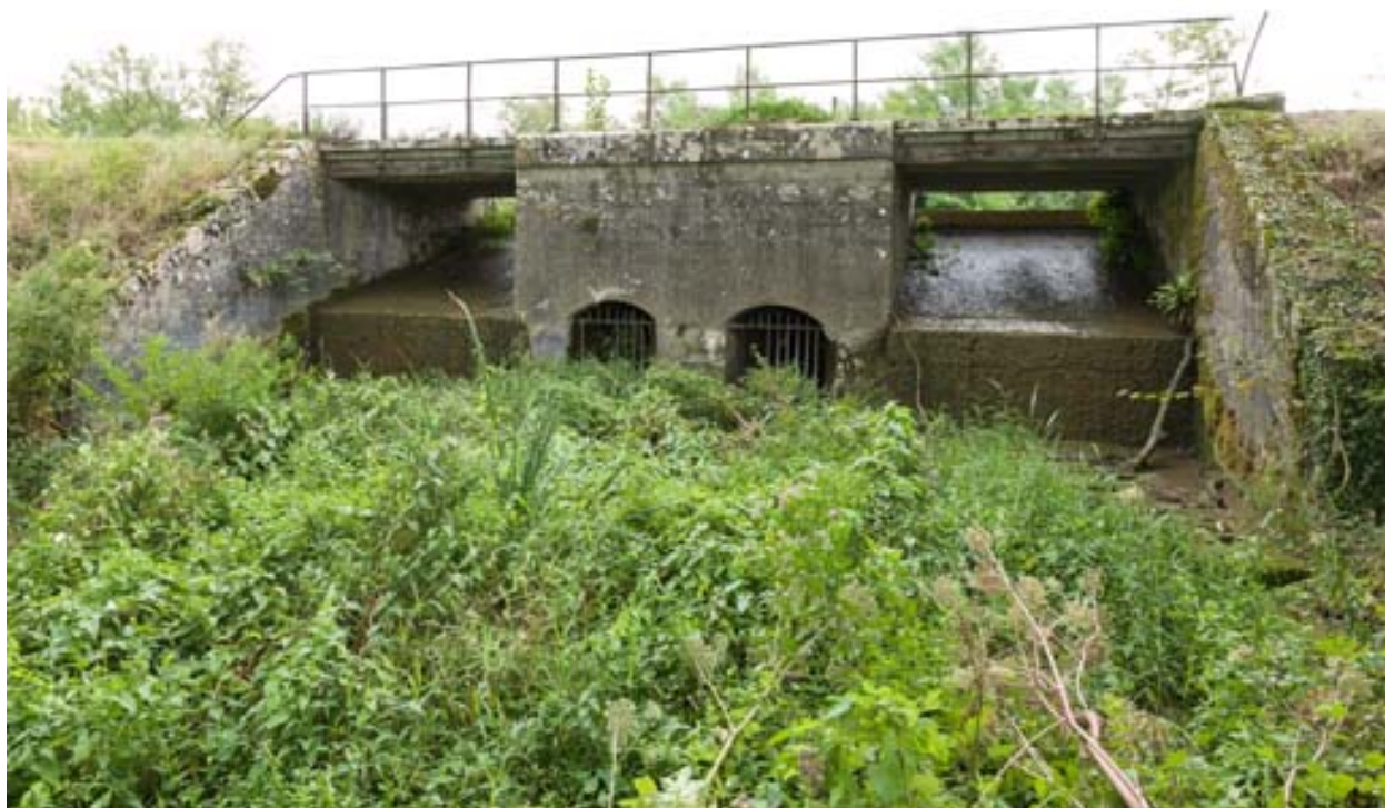
Vue du déversoir.
