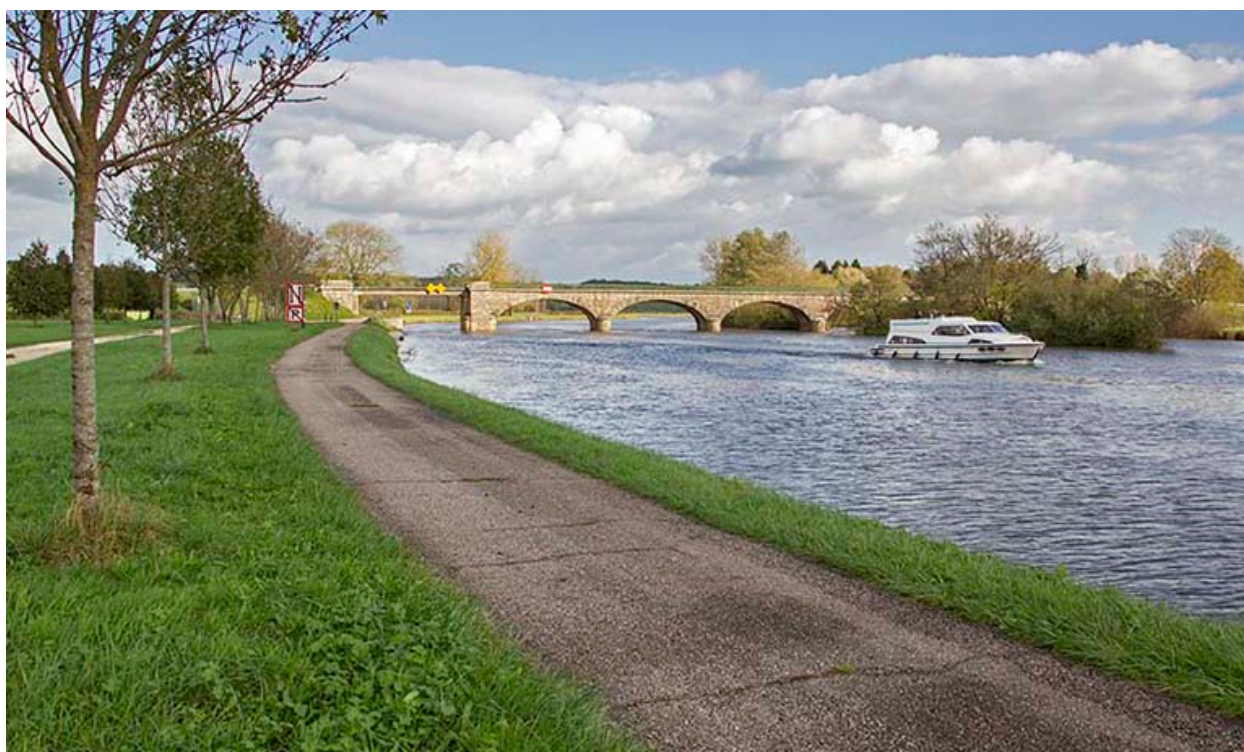
Vue depuis l'aval.
