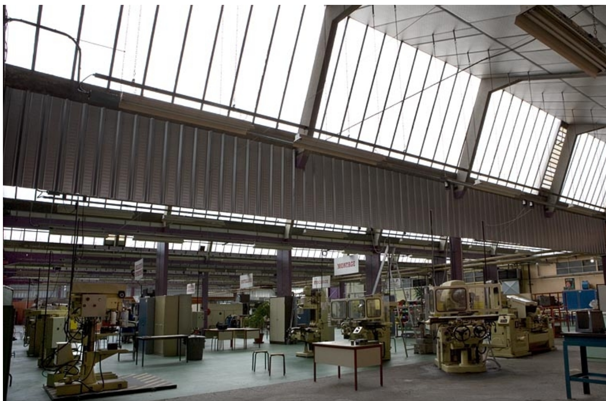
Bâtiment B. Atelier section technologique.
