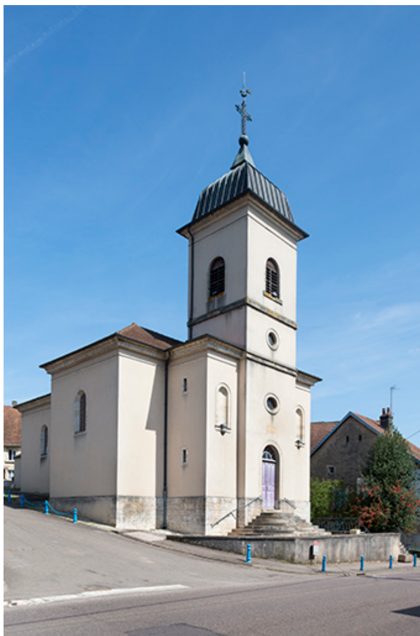
La chapelle depuis la rue Saint-Valère.
