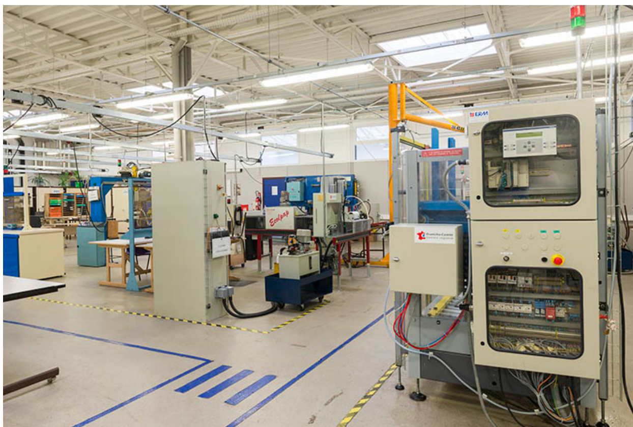
Vue intérieure d'un atelier.
