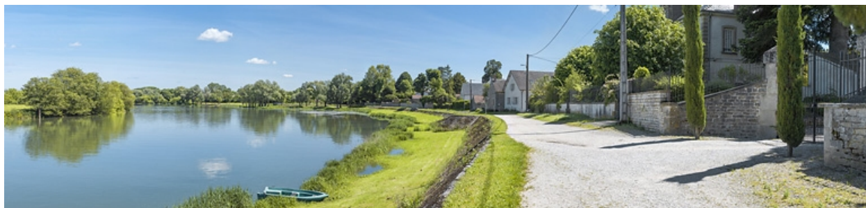
Vue d'ensemble de la digue, prise d'aval.
