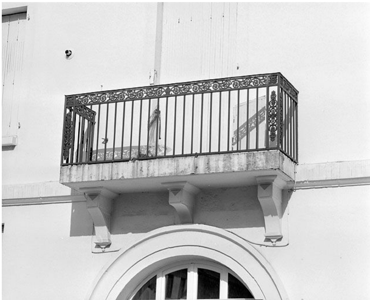
Façade latérale droite : balcon du premier étage.
