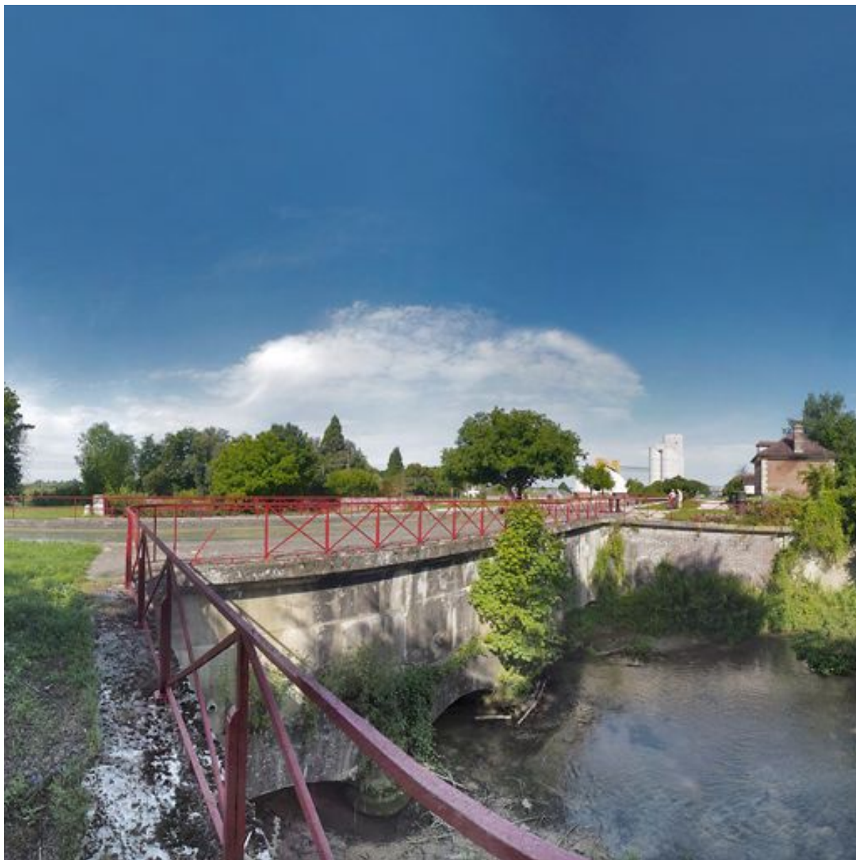
Pont canal de Brienon-sur-Armançon.
