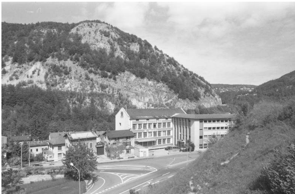
Vue d'ensemble de la façade antérieure.
