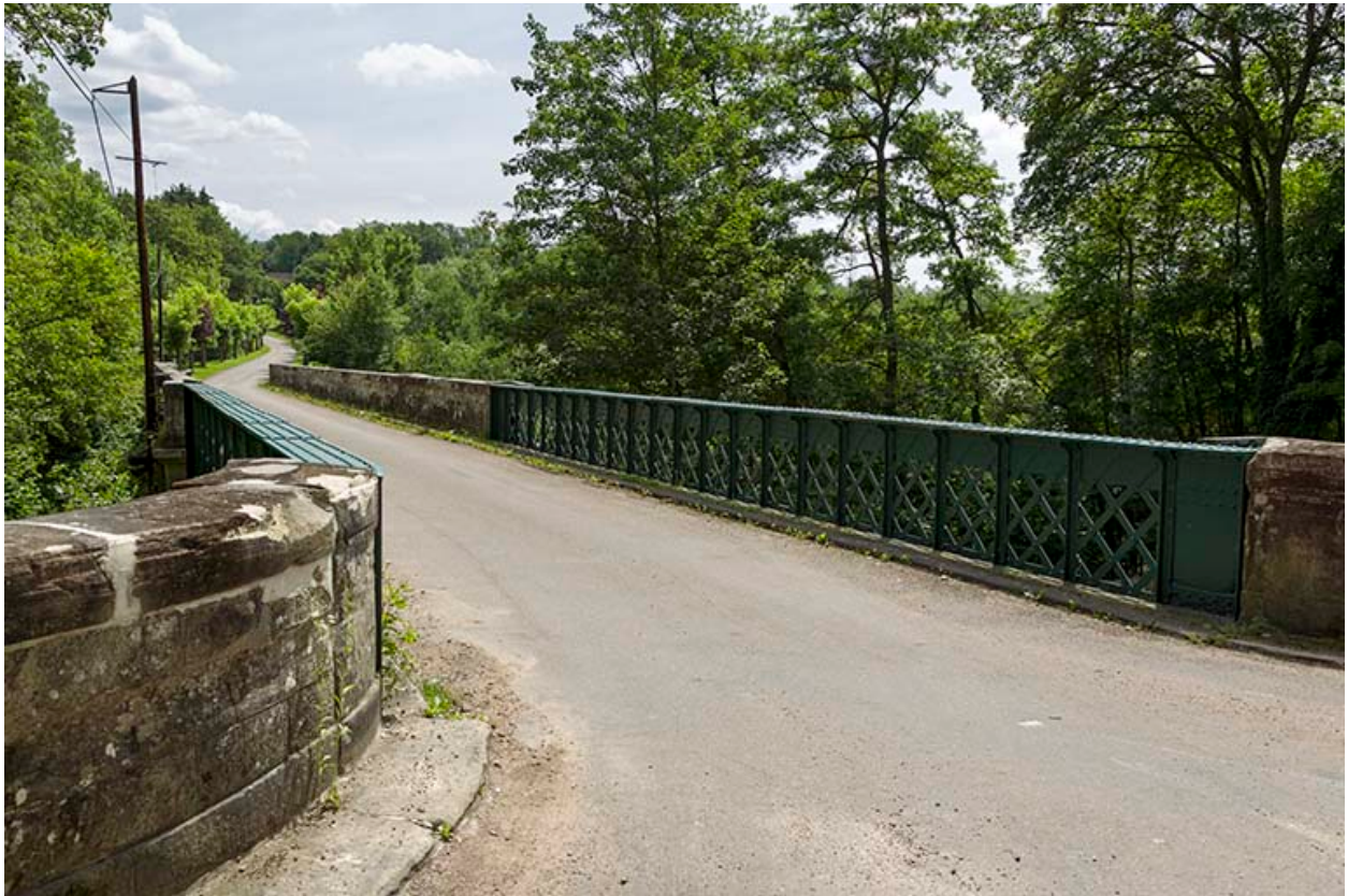
Vue de la passerelle depuis la route.
