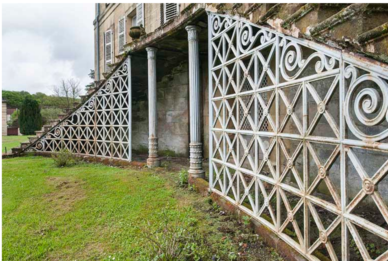
Structure métallique soutenant l'escalier.
