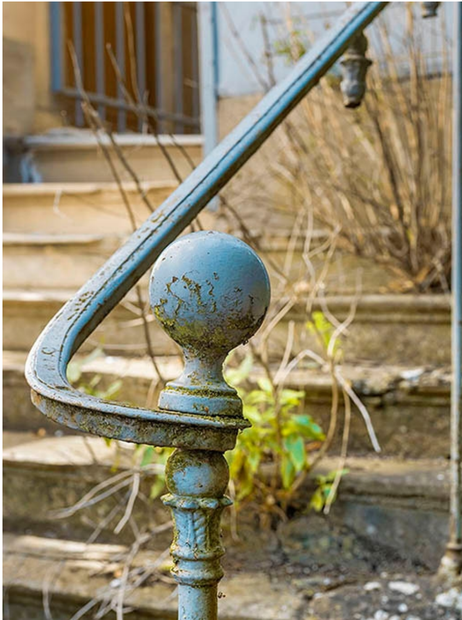
Départ de rampe : détail.
