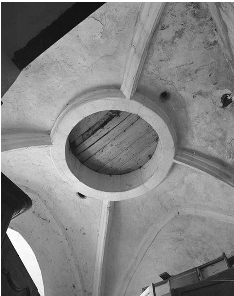
Clocher, niveau inférieur : voûte.
