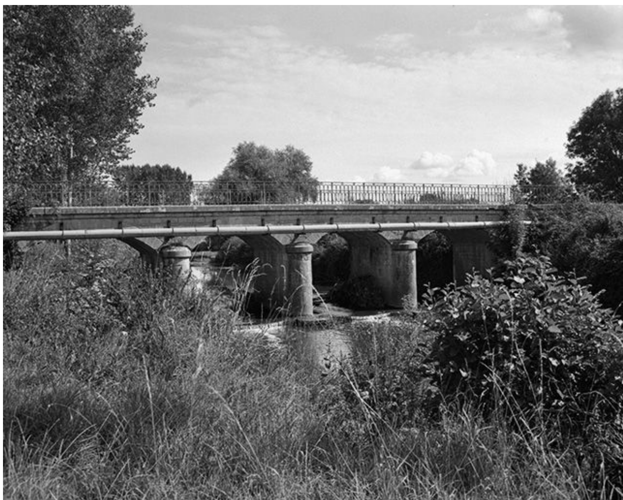
Courlaoux : pont sur la Vallière.
