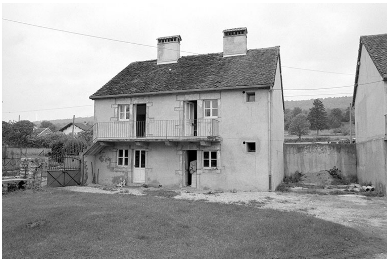
Façade sur cour d'un logement ouvrier.
