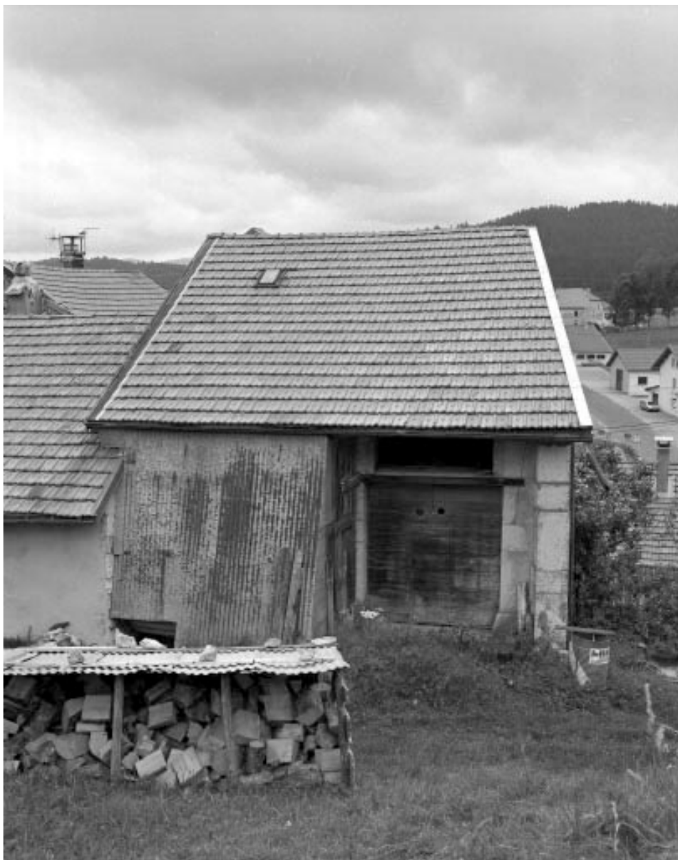
La rue Derrière, accès à une grange.
