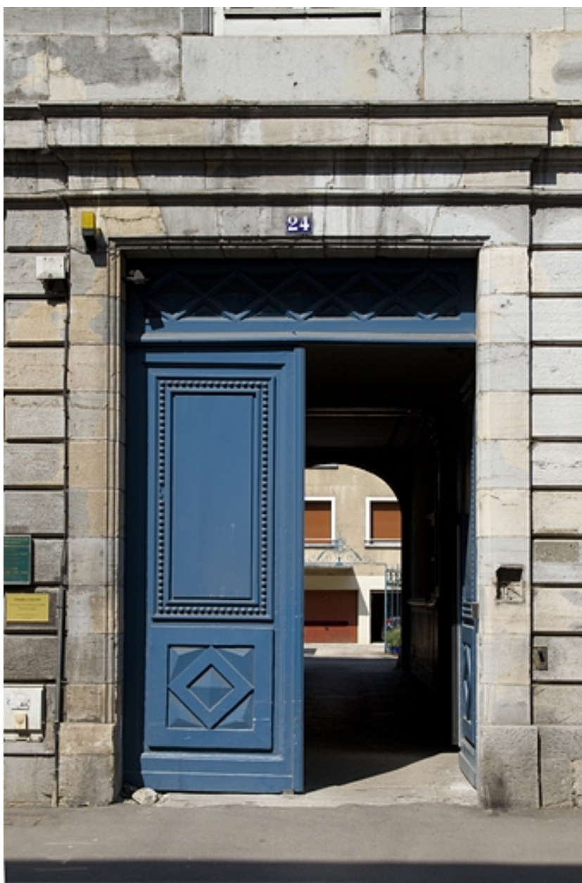
Détail du portail d'entrée.
