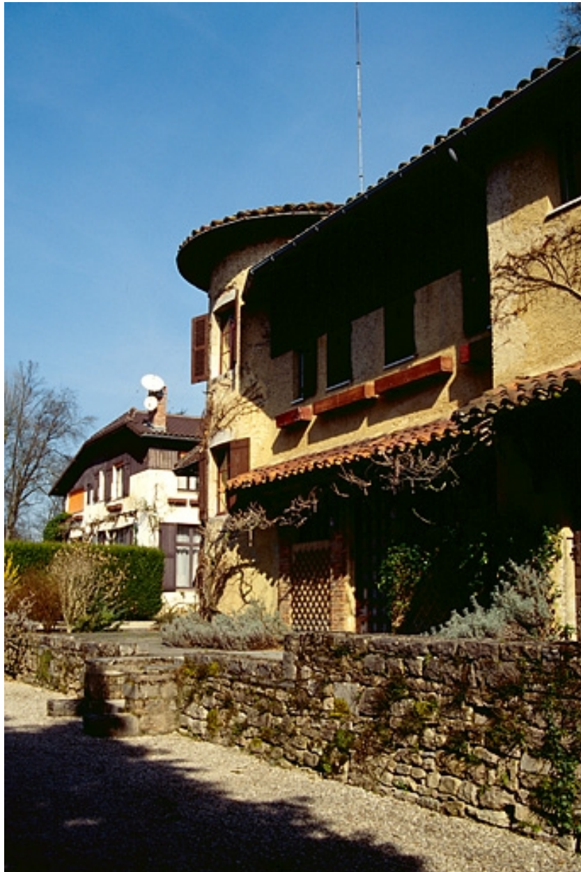
Façades antérieures des logements patronaux (O, P).
