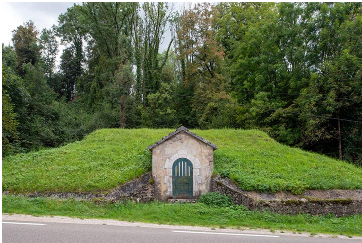
Réservoir de Veley (1910). Vue de face.
