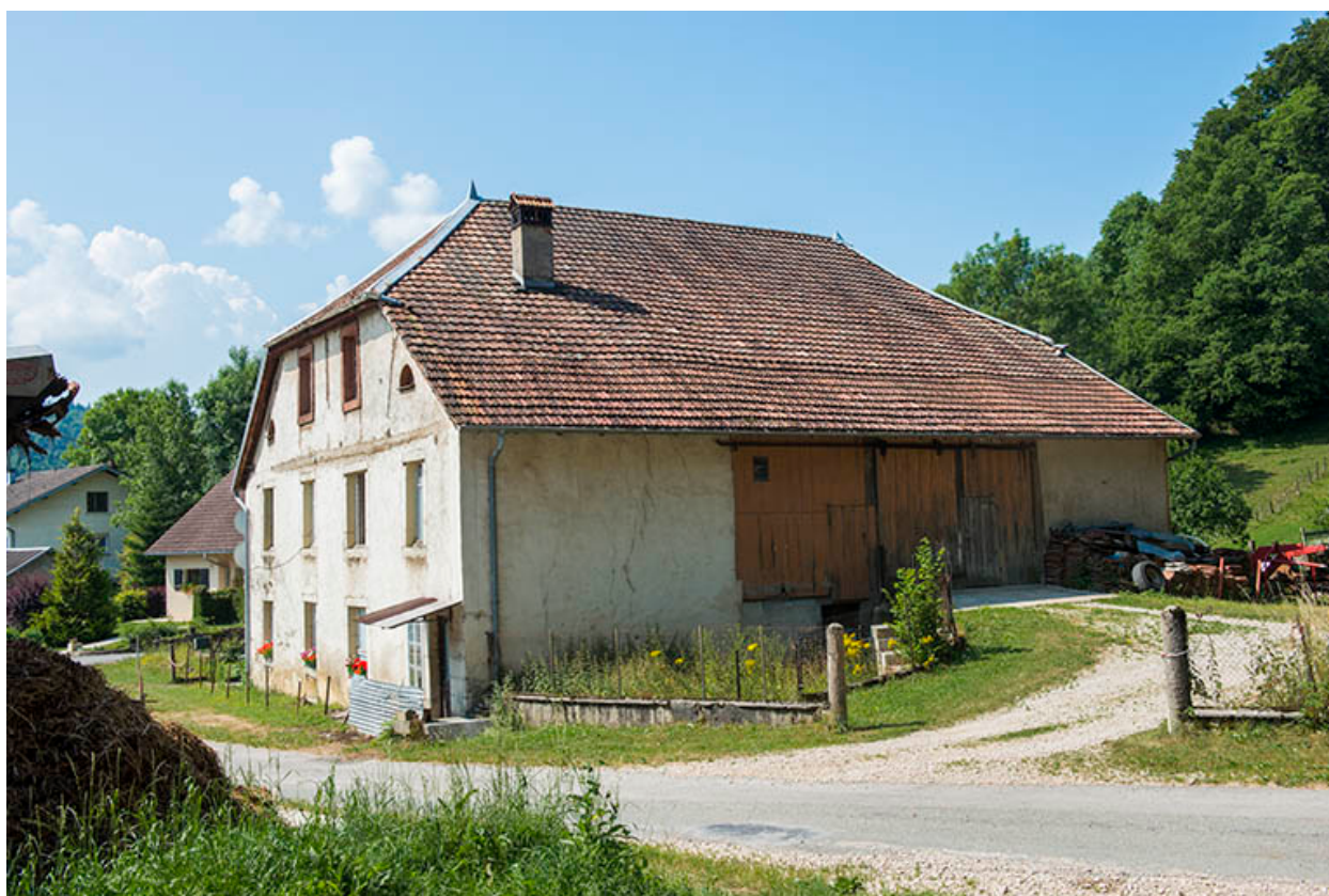
Façades postérieure et latérale droite.
