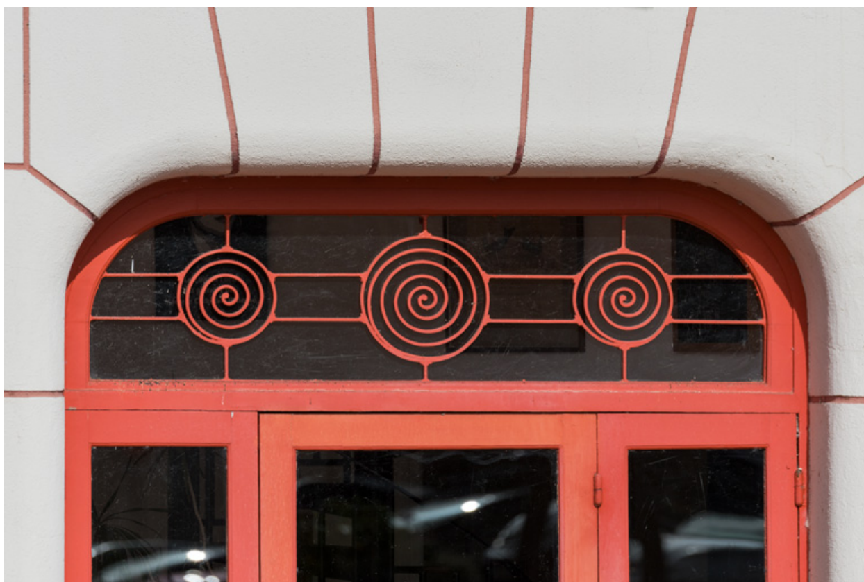
Façade antérieure : ferronnerie de la baie centrale.
