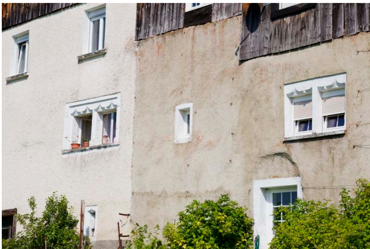
Façade latérale droite : baies.
