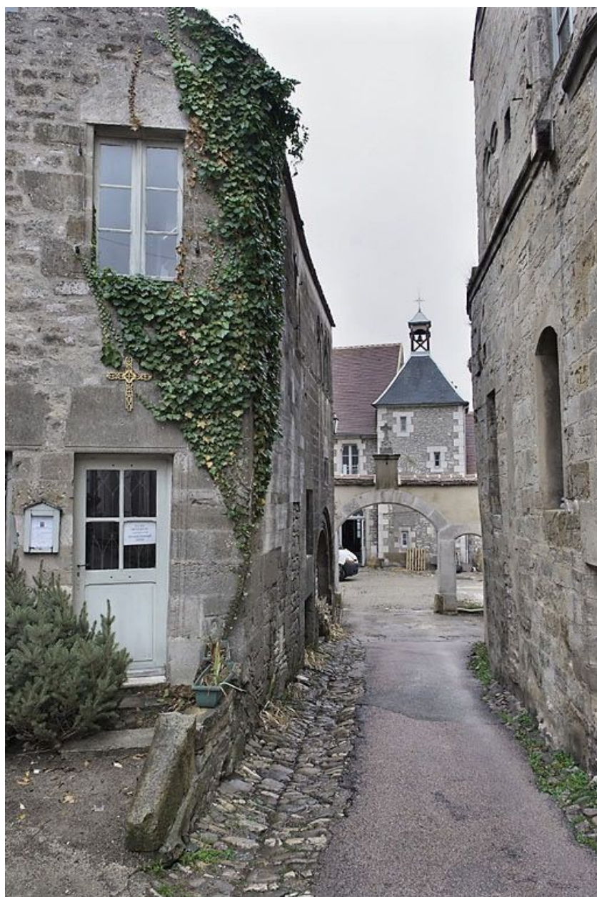
Vue d'ensemble depuis la rue du Couvent.
