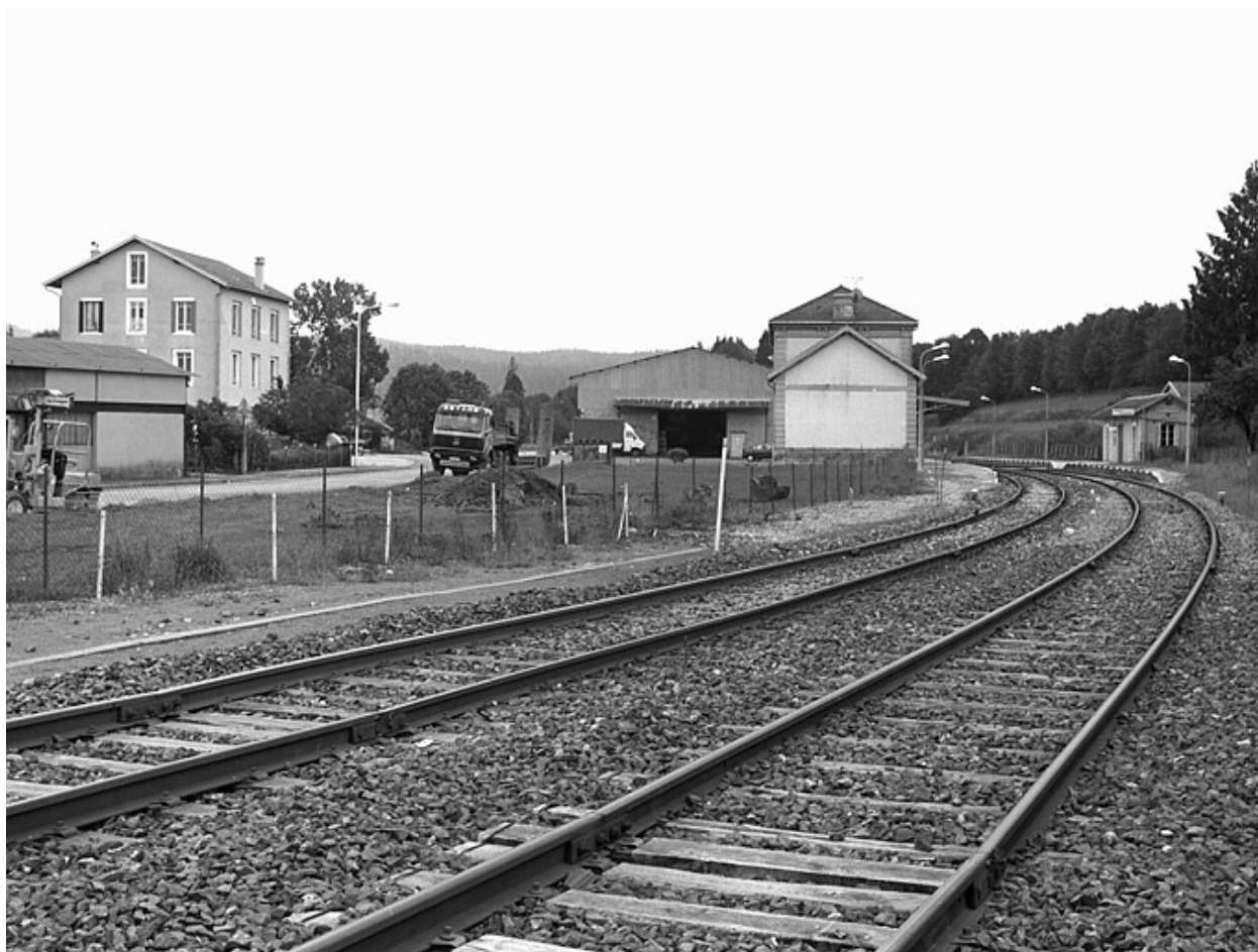
Vue d'ensemble, depuis le nord (côté Andelot-en-Montagne).
