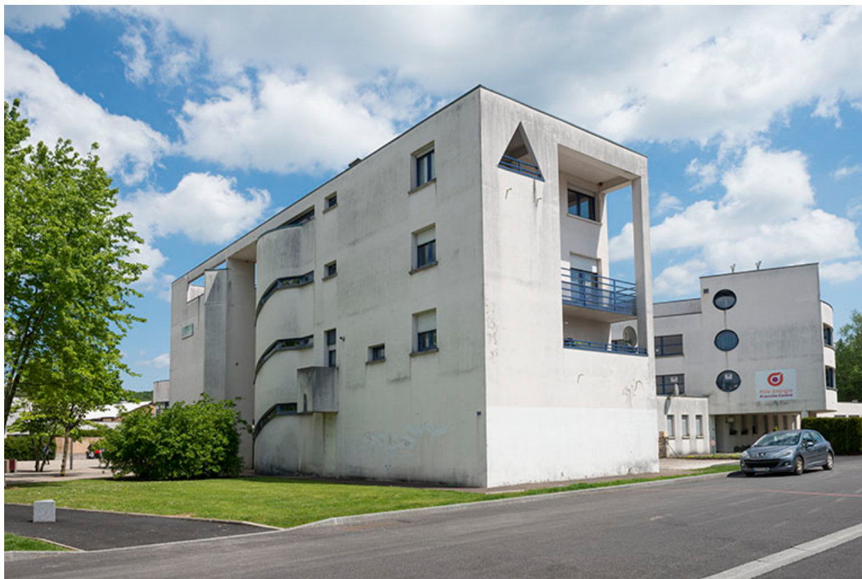
Vue depuis l'angle nord-ouest des logements sud-ouest.
