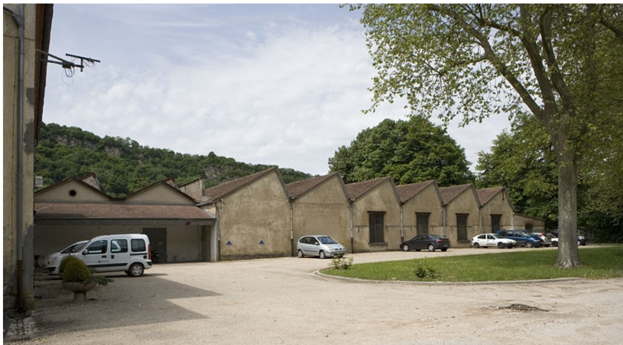
Entrepôt industriel. Pignons des sheds.
