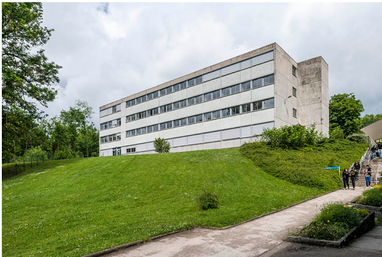
Façade sud de l'internat de garçons.
