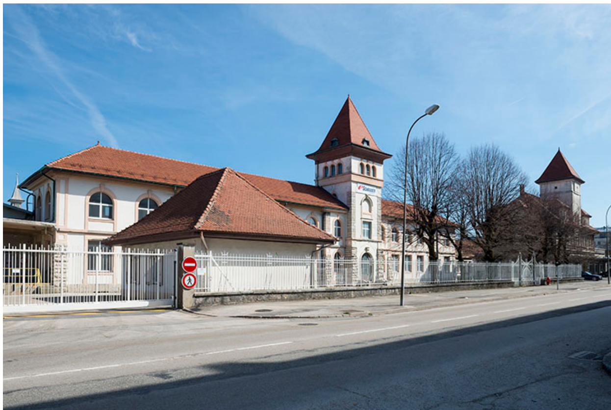
Bâtiments d'entrée, depuis l'ouest.
