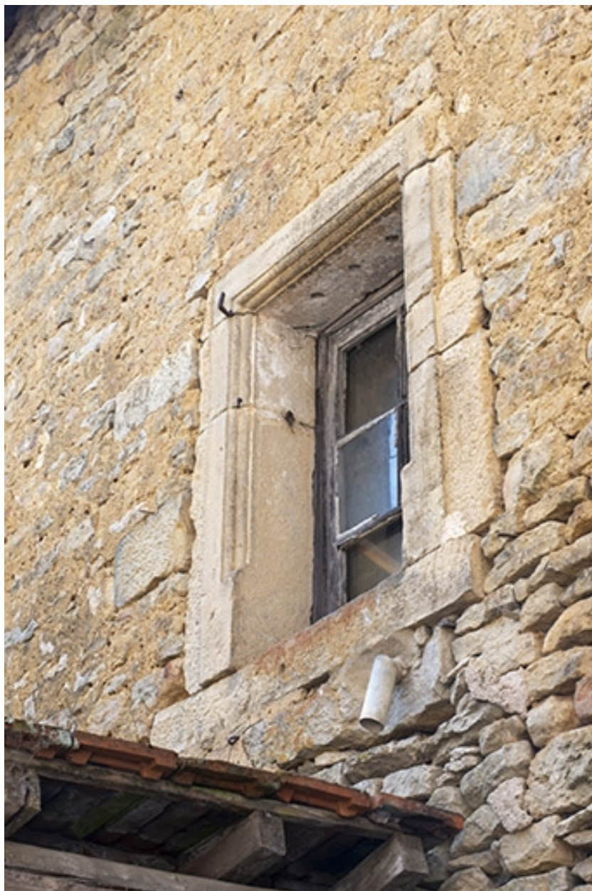
Une baie de l'étage, côté cour.
