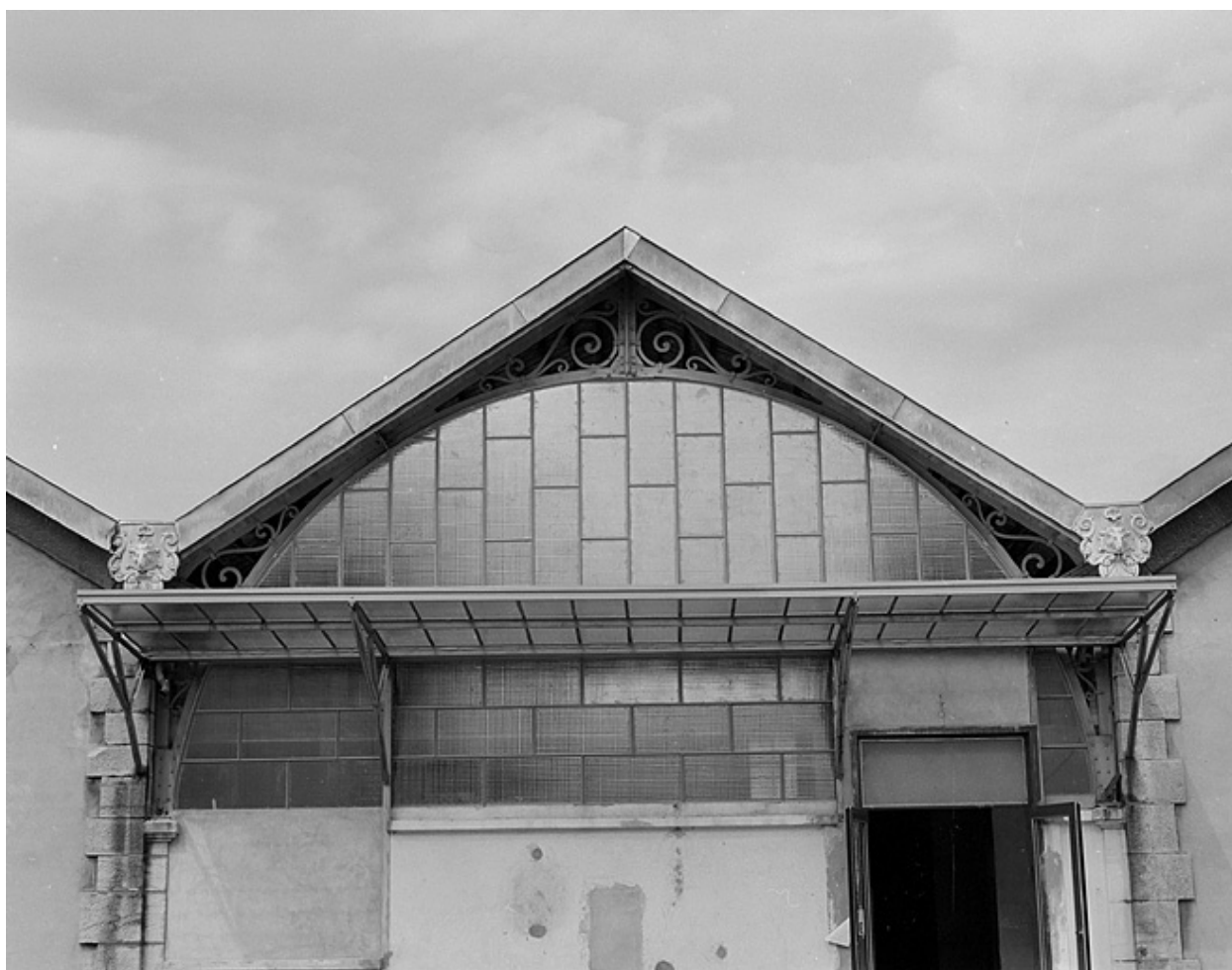
Détail de la couverture de la halle.
