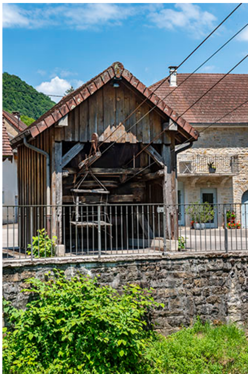
2020. Vue rapprochée du transporteur automatique par câbles.
