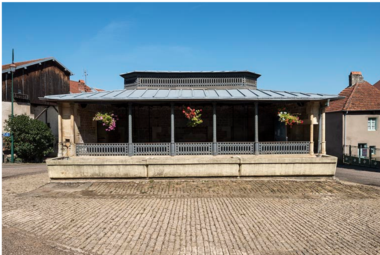
La façade antérieure de l'édifice.
