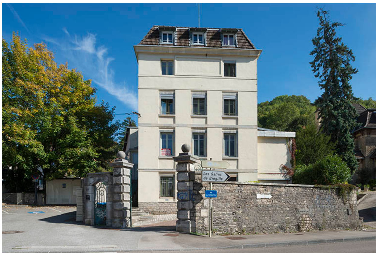
Façade ouest de l'atelier de fabrication.
